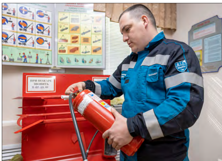
Проводится проверка комплектации противопожарного оборудования / ФОТО СЕРГЕЯ ТРУСОВА
